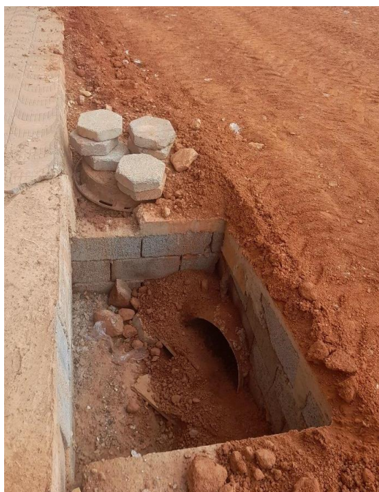
Foto 18 – Caixa de boca-de-lobo construída em via a ser pavimentada
