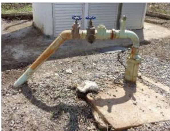
Foto 12 – Vista do poço de captação
