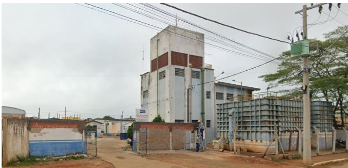
Foto 11– Vista da Estação de Tratamento de Água (ETA)
