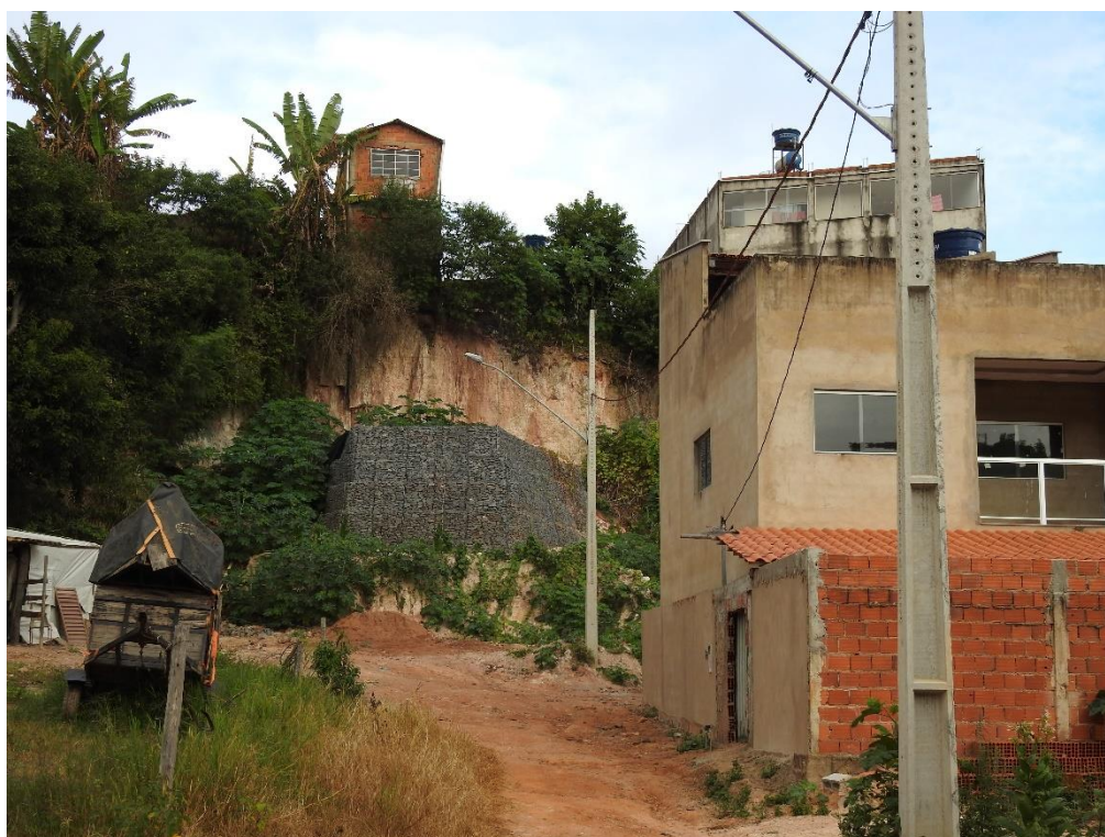
Foto 30 – Vista de um trecho de encosta instável no centro da sede do município.
