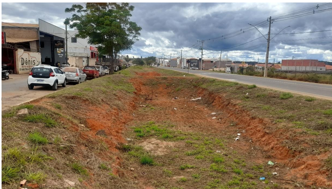
Foto 23 – Valas secas localizadas na rua Estados Unidos para armazenar as águas de chuva
