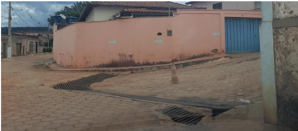
Foto 20 – Captação de água de chuva por meio de grelhas (final da Travessa Geral da Novata)
