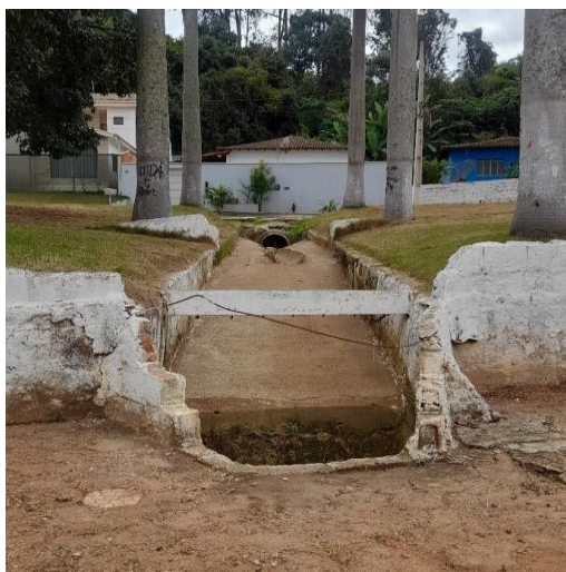
Foto 22 – Dispositivos de drenagem antigos (Praça Norma Pimenta) – canal de transposição de água de chuva
