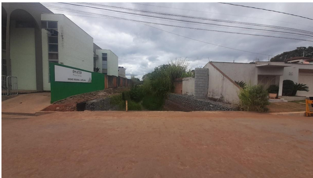
Foto 28 – Canalização em gabião do córrego Areão e edificações construídas em APP
