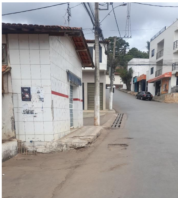
Foto 27 – Trecho canalizado do córrego Areão que passa embaixo do mercado municipal
