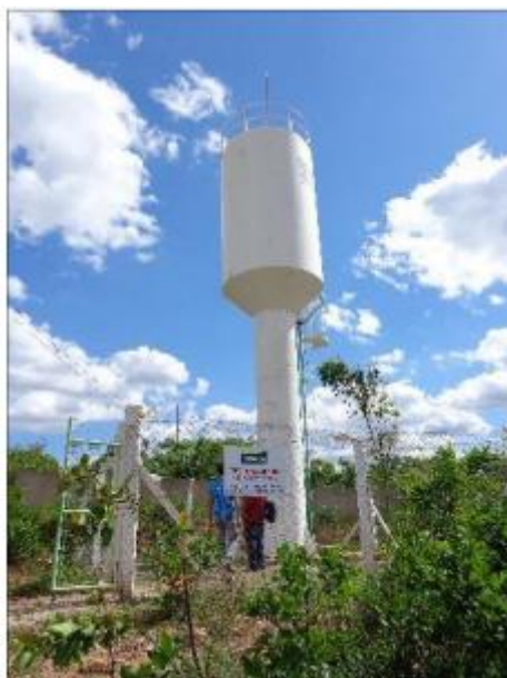
Foto 15 – Reservatório elevado com capacidade de 30m³
