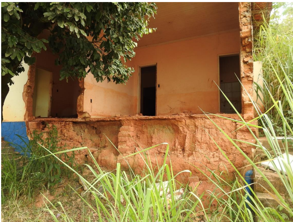
Foto 33 - Detalhe para edificação atingida por corrida de lama. Destruição parcial do imóvel
