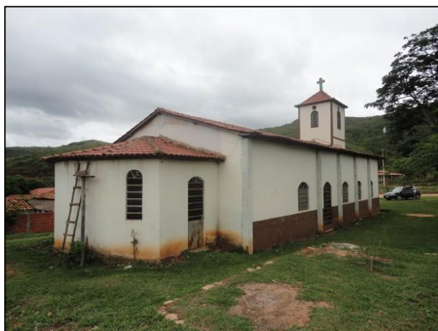
Vista dos fundos
