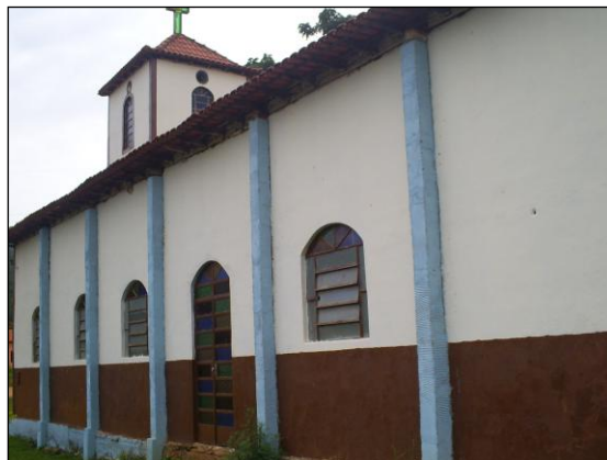
Vista fachada lateral esquerda
