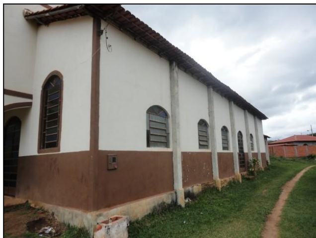
Vista fachada lateral esquerda
