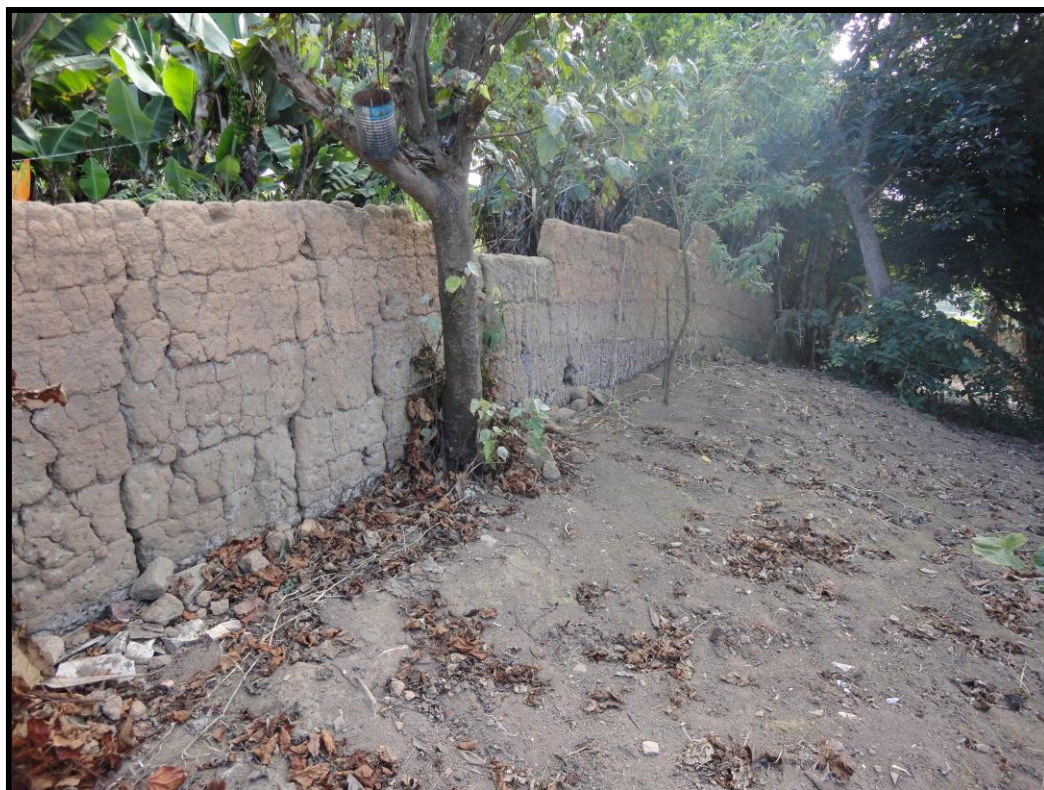
Muro de Taipa
