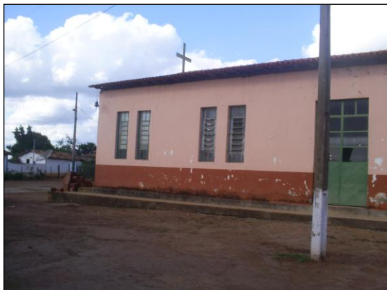
Fachada lateral esquerda
