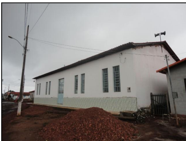
Fachada lateral esquerda
