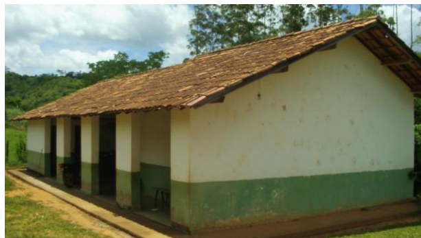
Foto12: Escola Municipal da Comunidade de Gouveia 2, funcionando regularmente com ensino fundamental.
