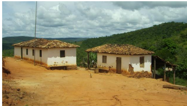
Foto11: Construções típicas da região, em estilo colonial mineiro
