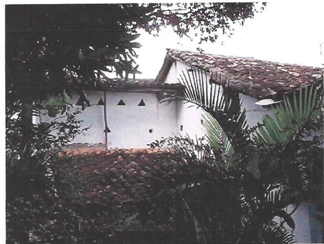
FIG. 02 – Fachada posterior da edificação, em detalhe à cobertura.
