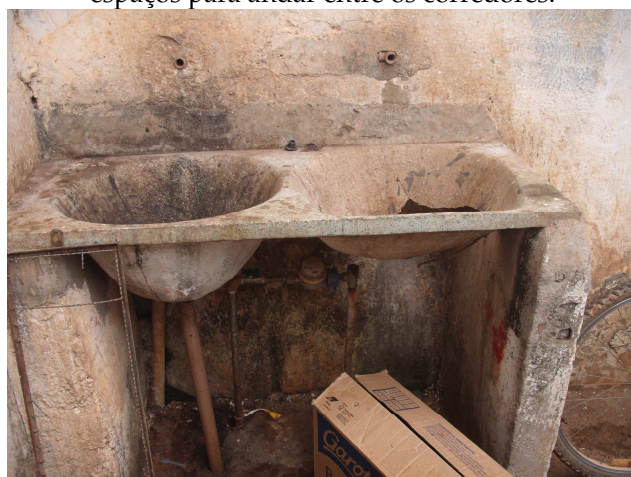
Tanques quebrados e sem torneiras
