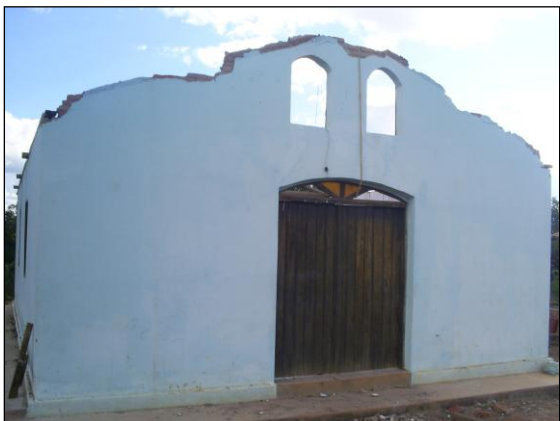
Fachada em processo de intervenção
