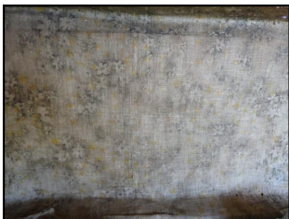
Detalhe da forragem interna
