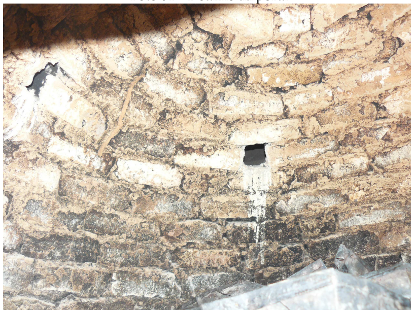
Foto 05 – Detalhe do interior
