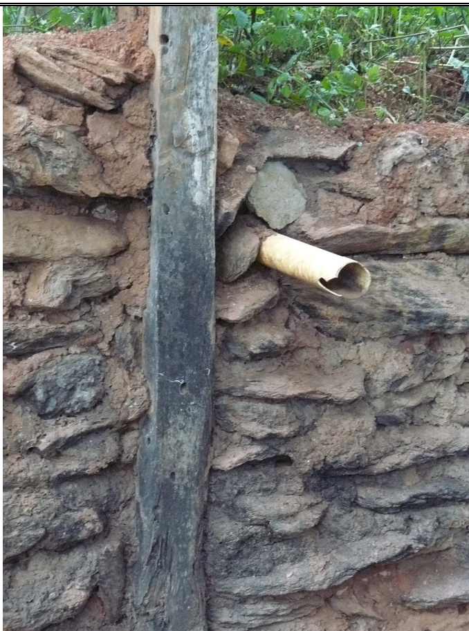
Foto 08 – Detalhe do cano por onde desce o caldo da cana
