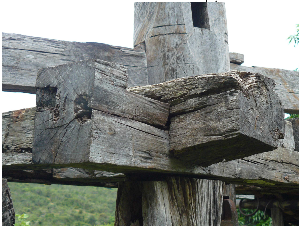
Foto 07 – Detalhe do encaixe das madeiras
