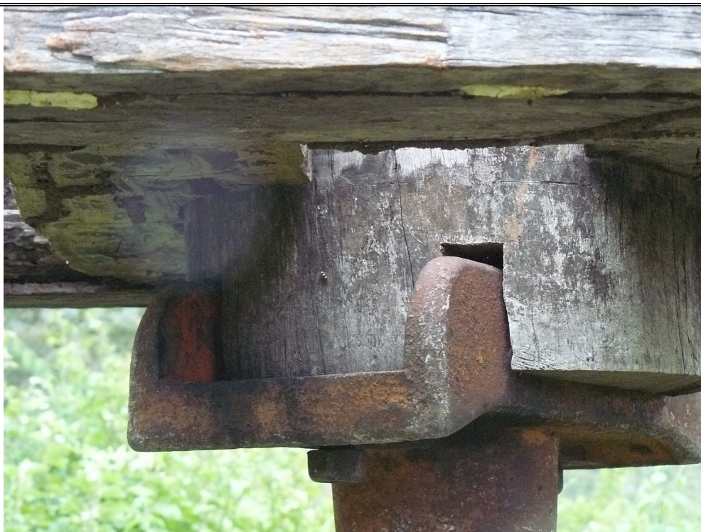
Foto 06 – Detalhe do encaixe do cilindro com a peça de madeira
