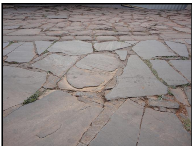
Detalhe da pavimentação em Pedras (Lapas)
