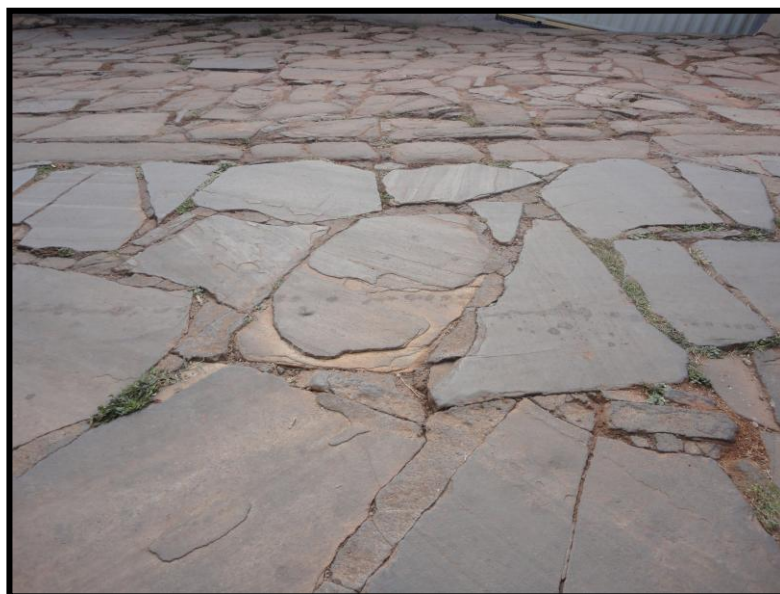
Detalhe da Pavimentação
