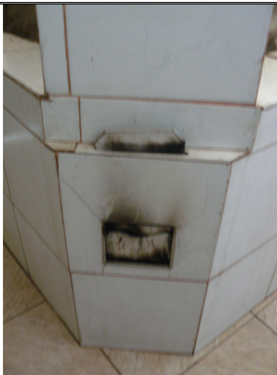
Foto 8- Forno para aquecimento do alambique
