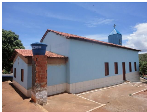
Fundos e fachada lateral direita
