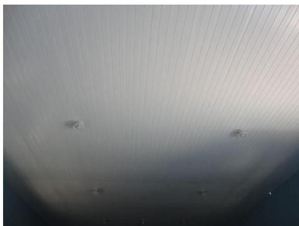
Forro PVC recém implantado
