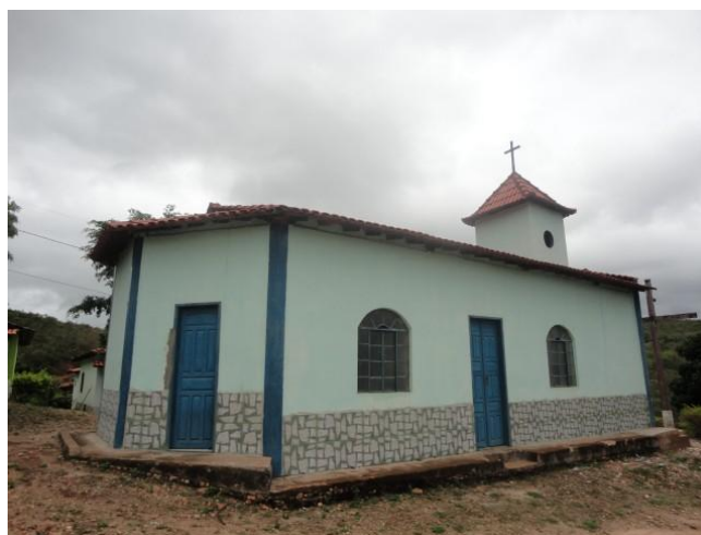
Vista fachada lateral direita.
