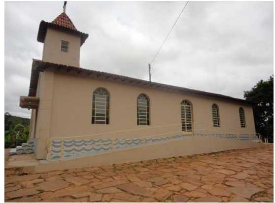
Fachada lateral esquerda – calçada e corrimão recém implantados
