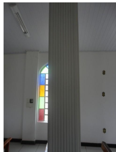
Pilares de cimento revestidos de gesso recém implantados
