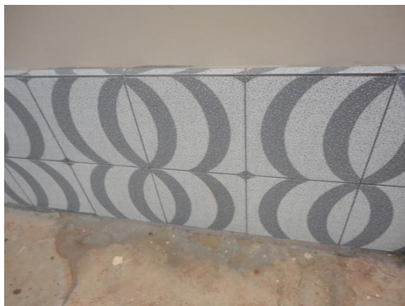
Barrado de cerâmica recém implantado
