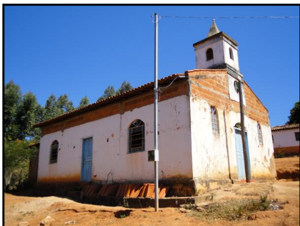
Fachada e lateral esquerda
