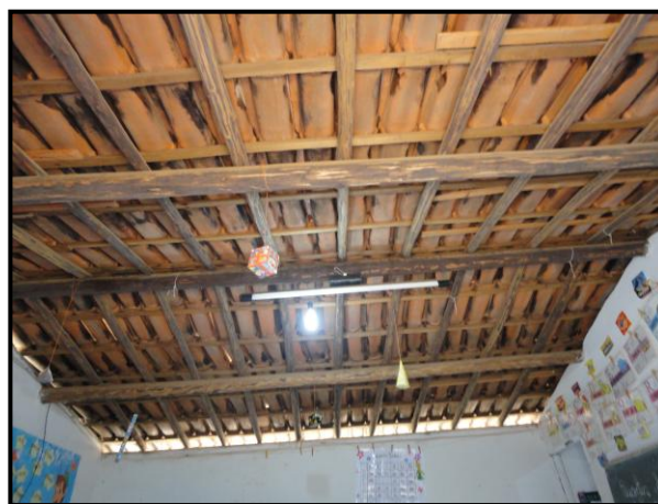
Detalhe do telhado
