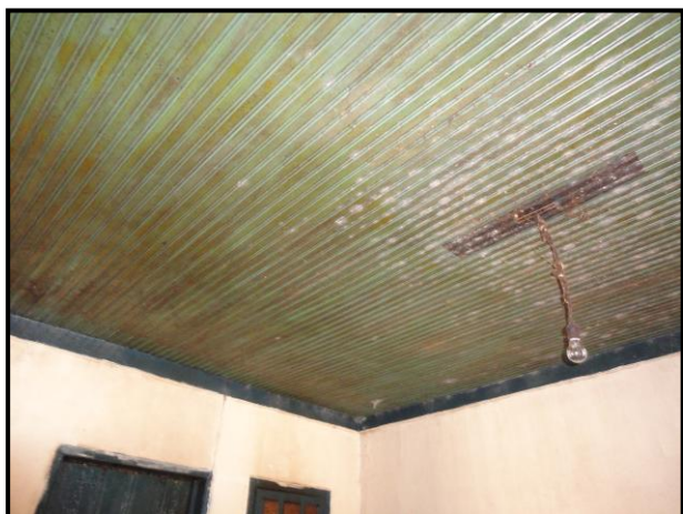
Forro em madeira
