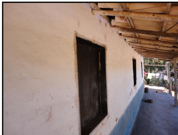
detalhe da caiação externa
