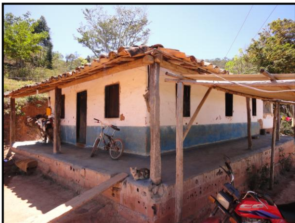
Fachada e lateral esquerda
