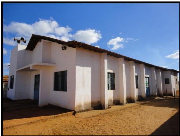
Fachada e lateral esquerda
