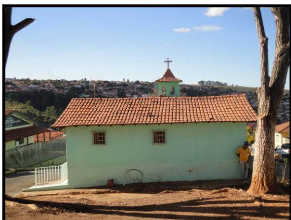
Parte posterior da Capela (bloqueando a visualização o prédio do escritório paroquial)
