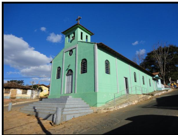
Fachada e lateral esquerda
