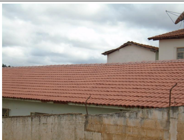
Escola Estadual Dr. Juscelino Barbosa – Visão da cobertura de telhas de cerâmica. Data: 30/06/2017. Fotógrafo: Pedro Alcântara. Fotografias: Digitais.
