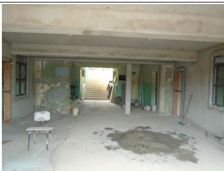
Escola Estadual Dr. Juscelino Barbosa – Visão geral interna do 1º pavimento, em obras. Data: 30/06/2017. Fotógrafo: Pedro Alcântara. Fotografias: Digitais.
