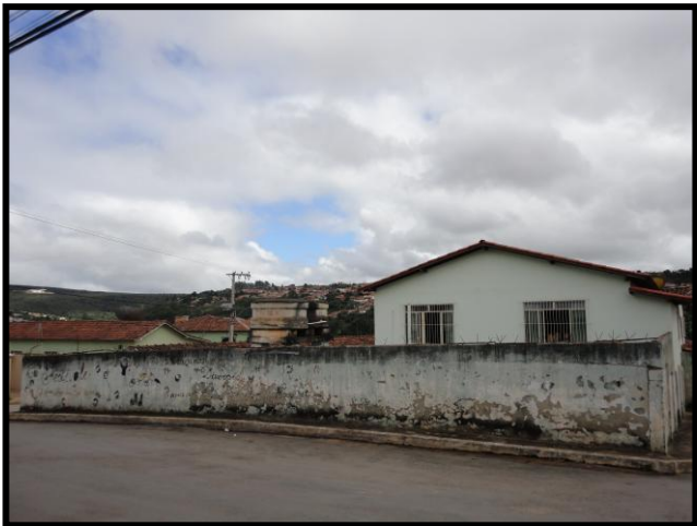
Vista dos fundos
