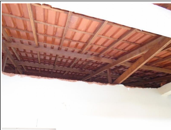
Escola Estadual Dr. Juscelino Barbosa – Visão da armação do telhado. Data: 30/06/2017. Fotógrafo: Pedro Alcântara. Fotografias: Digitais.
