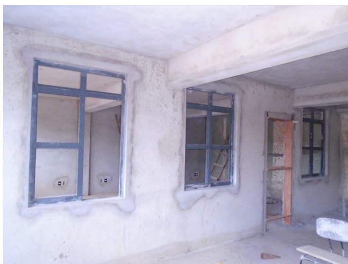
Escola Estadual Dr. Juscelino Barbosa – Salas em construção no primeiro piso. Data: 30/06/2017. Fotógrafo: Pedro Alcântara. Fotografias: Digitais.
