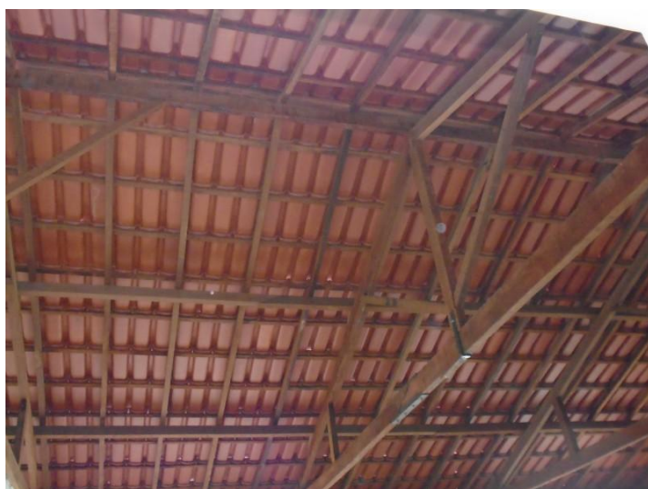
Escola Estadual Dr. Juscelino Barbosa – Visão geral do telhado, 2º piso. Data: 30/06/2017. Fotógrafo: Pedro Alcântara. Fotografias: Digitais.
