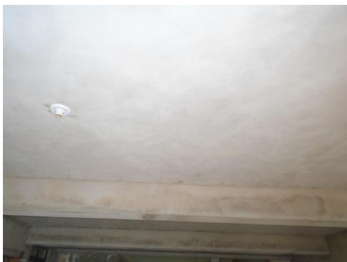
Escola Estadual Dr. Juscelino Barbosa –Laje das salas em construção. Data: 30/06/2017. Fotógrafo: Pedro Alcântara. Fotografias: Digitais.
