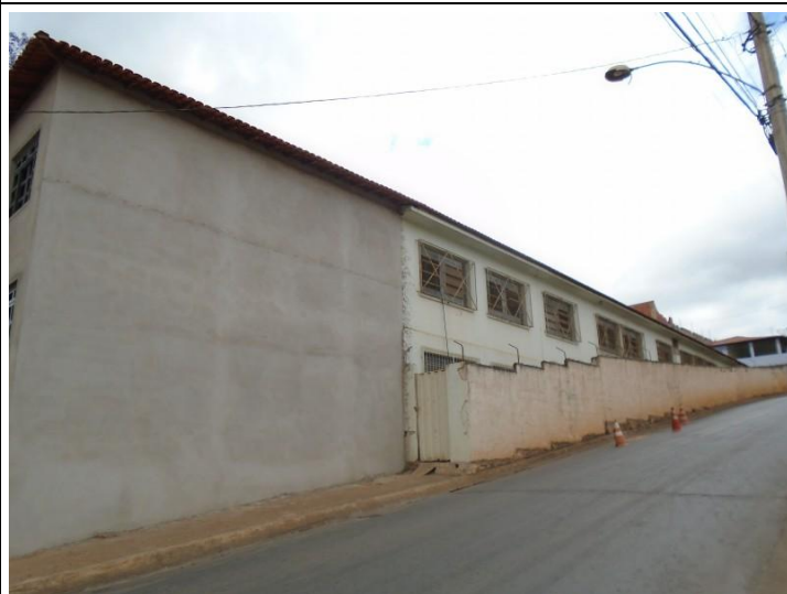
Escola Estadual Dr. Juscelino Barbosa – Visão geral da lateral esquerda, com as salas em construção. Data: 30/06/2017. Fotógrafo: Pedro Alcântara. Fotografias: Digitais.
