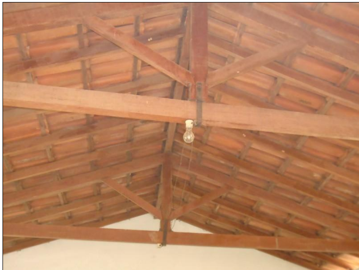
Cemitério Municipal de Capelinha – Telhado da capela. Fotógrafo: Pedro Alcântara. Data: 20/06/2018. Fotografias: Digitais.
