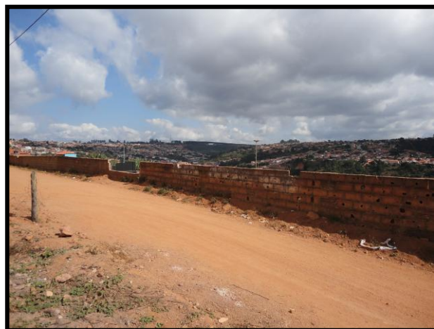
Muro da parte traseira
