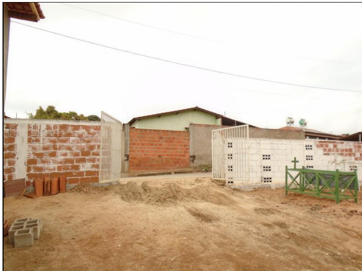
Cemitério Municipal de Capelinha – Portão à fachada lateral esquerda. Fotógrafo: Pedro Alcântara. Data: 20/06/2018. Fotografias: Digitais.
