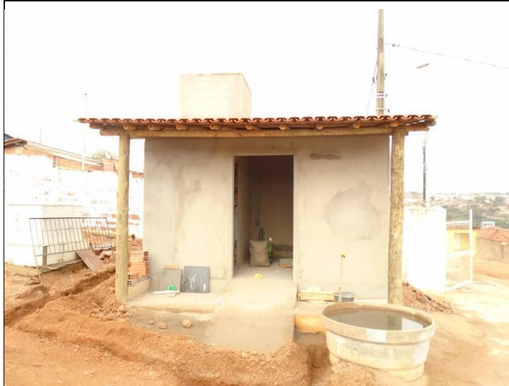
Cemitério Municipal de Capelinha – Construção de prédio à entrada. Fotógrafo: Pedro Alcântara. Data: 20/06/2018. Fotografias: Digitais.
