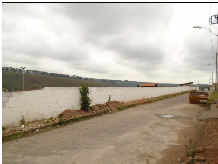
Cemitério Municipal de Capelinha – Muro à fachada lateral esquerda. Fotógrafo: Pedro Alcântara. Data: 20/06/2018. Fotografias: Digitais.
