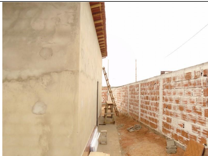
Cemitério Municipal de Capelinha – Construção de prédio aos fundos. Fotógrafo: Pedro Alcântara. Data: 20/06/2018. Fotografias: Digitais.
