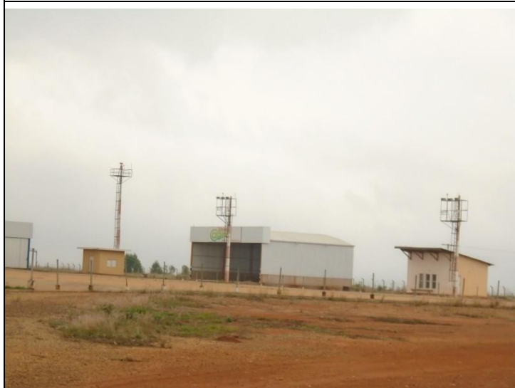
Aeroporto Dr. Juscelino José Ribeiro – Galpão e demais edificações. Fotógrafo: Pedro Alcântara. Fotografias: Digitais. Data: 16/05/2018.
