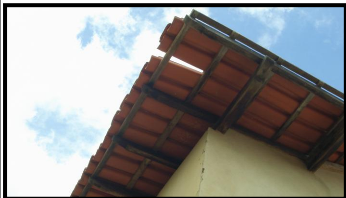
Vista do Beiral do telhado
