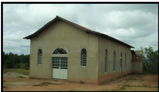
Fachada frontal e lateral direita
