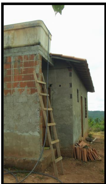
Vista dos fundos da Igreja
