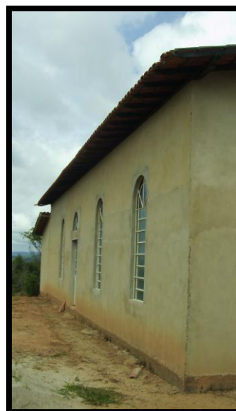
Vista da fachada lateral esquerda
