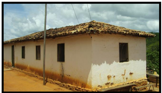
Vista da fachada frontal e lateral direita da residência maior
