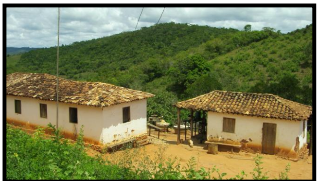
Visão das duas residências, da estrada
