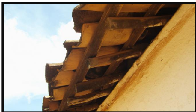
Vista do beiral de caibro corrido
