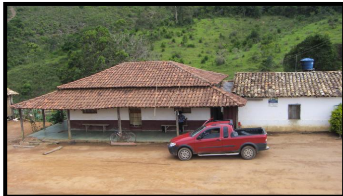
Vista da fachada frontal
