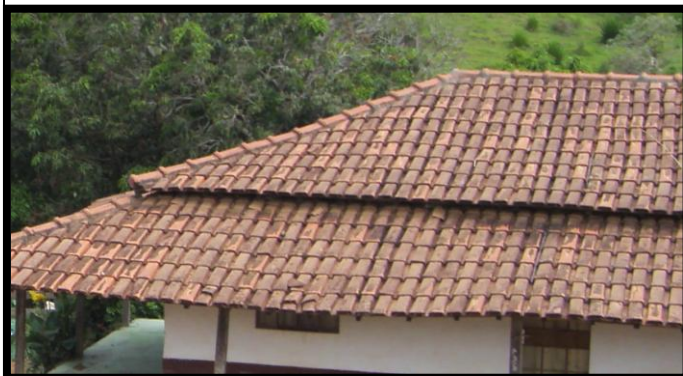
Telhado de Cerâmica
