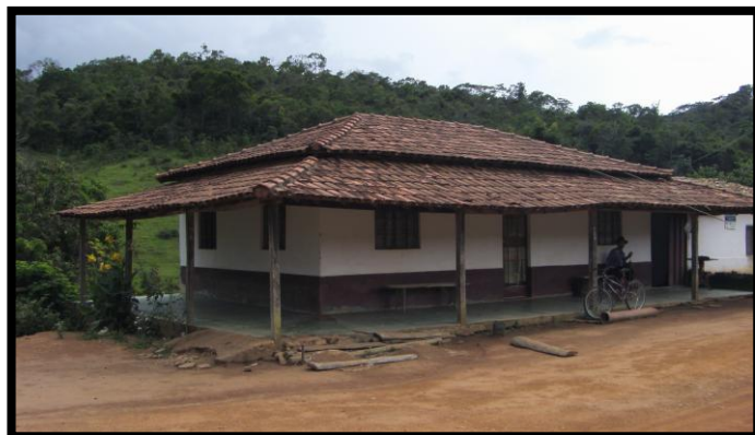
Fachada frontal e lateral esquerda
