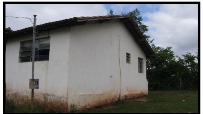
Vista dos fundos e da fachada lateral esquerda
