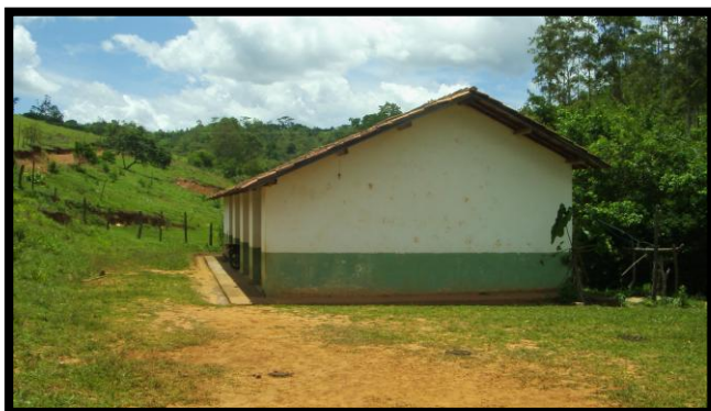
Fachada lateral esquerda
