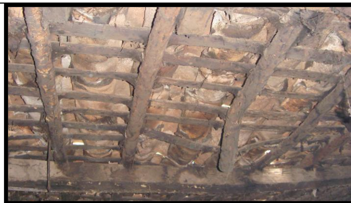
Estrutura do telhado, madeiramento rústico e sem tratamento
