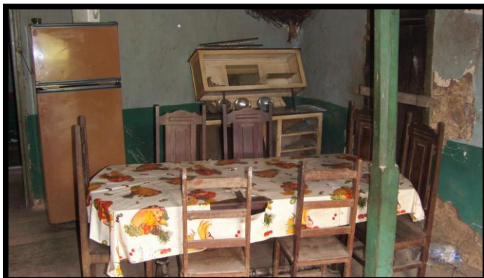
Poste de sustentação do telhado na cozinha
