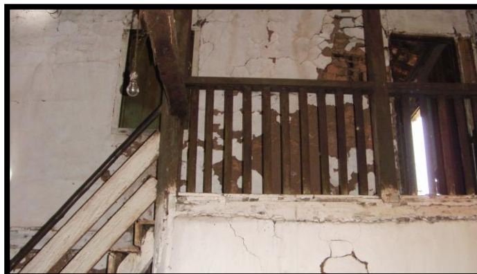
Escada de acesso do primeiro pavimento ao segundo
