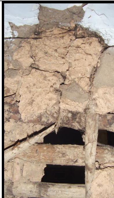
Detalhe da parede interna da cozinha
