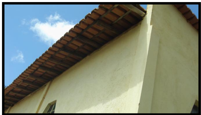
Vista da lateral esquerda: Detalhe do Beiral
