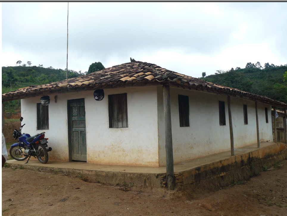
Foto 02 – Fazenda Sr. Antônio- Fachada Frontal e Lateral Direita
