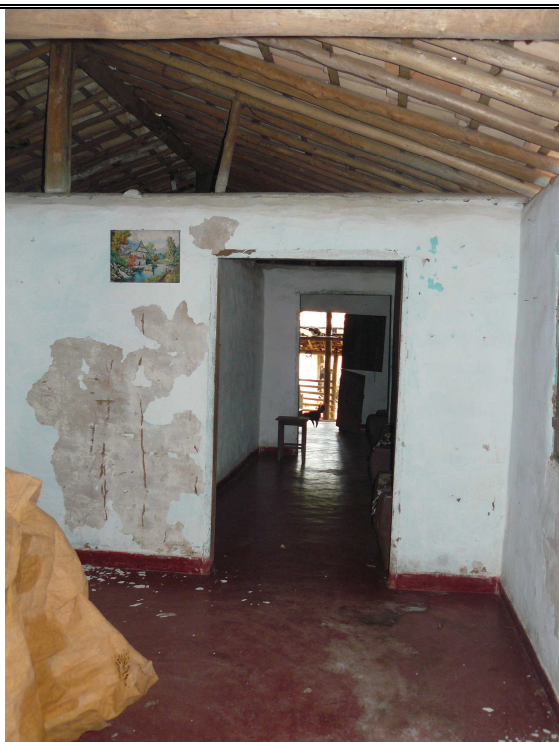
Foto 10- Fazenda Sr. Antônio- Vista Interna-Sala
