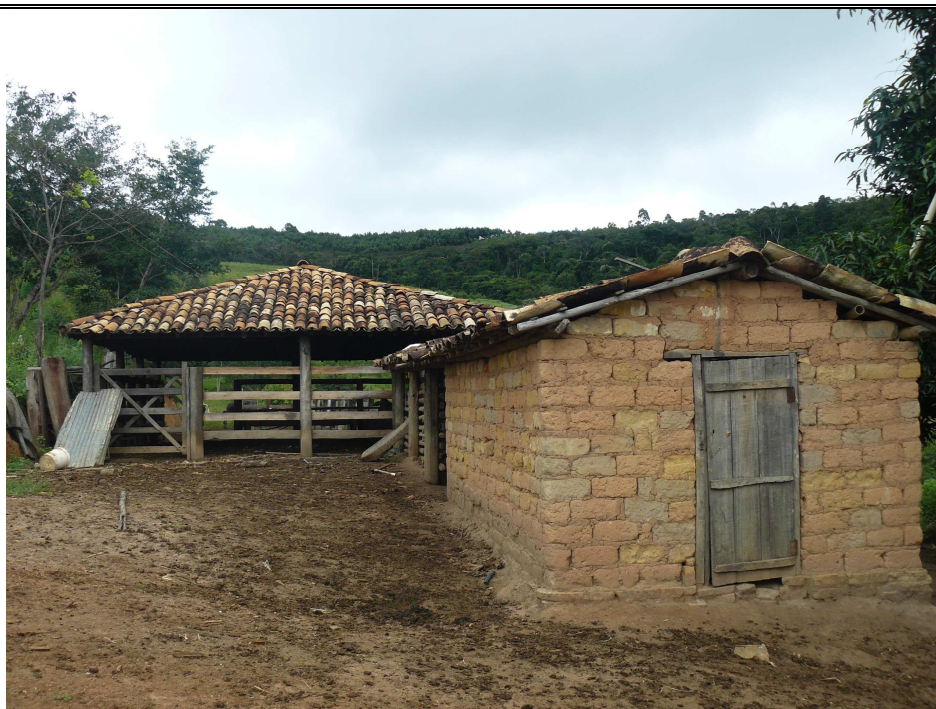
Foto 06- Fazenda Sr. Antônio- Vista Silo e Curral
