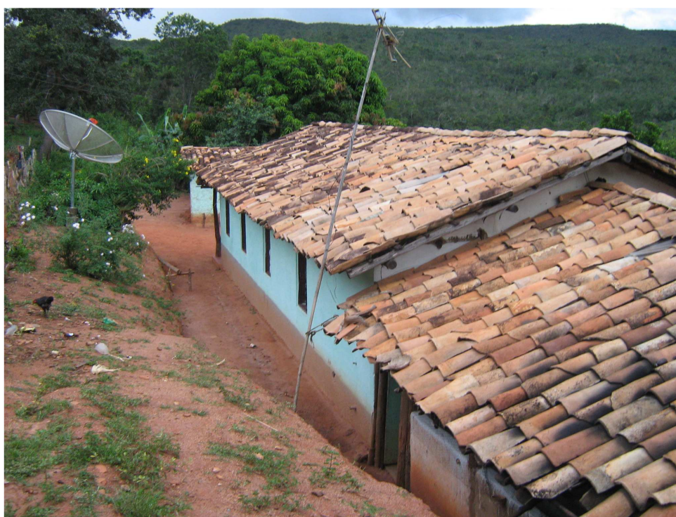
Foto 05 – Fazenda D. Elza – Fachada Lateral Direita Vista a partir do fundo
