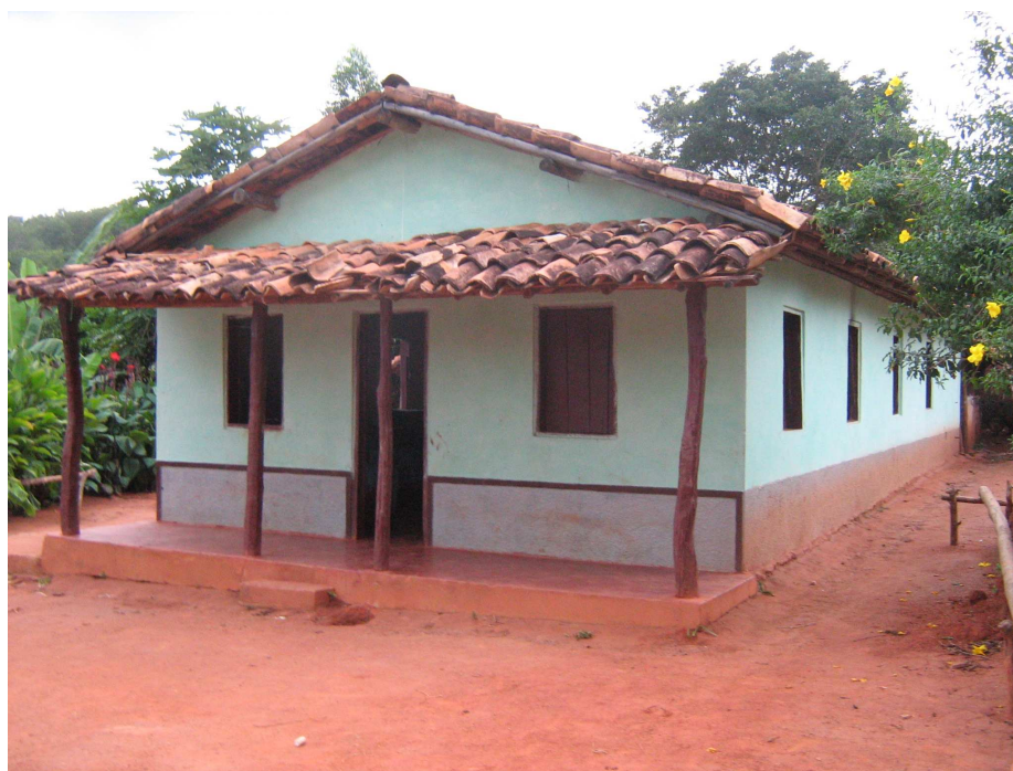
Foto 04 – Fazenda D. Elza – Fachada Frontal e Lateral Direita
