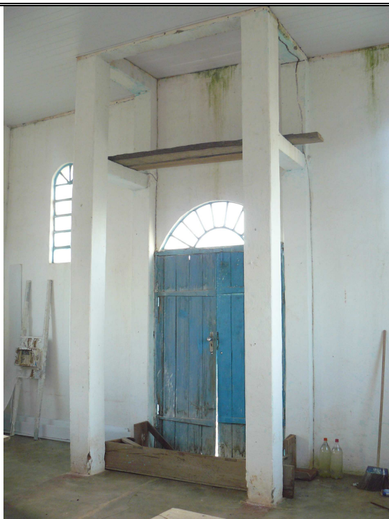
Foto 14- Igreja de Santa Terezinha – Detalhe Porta Principal
