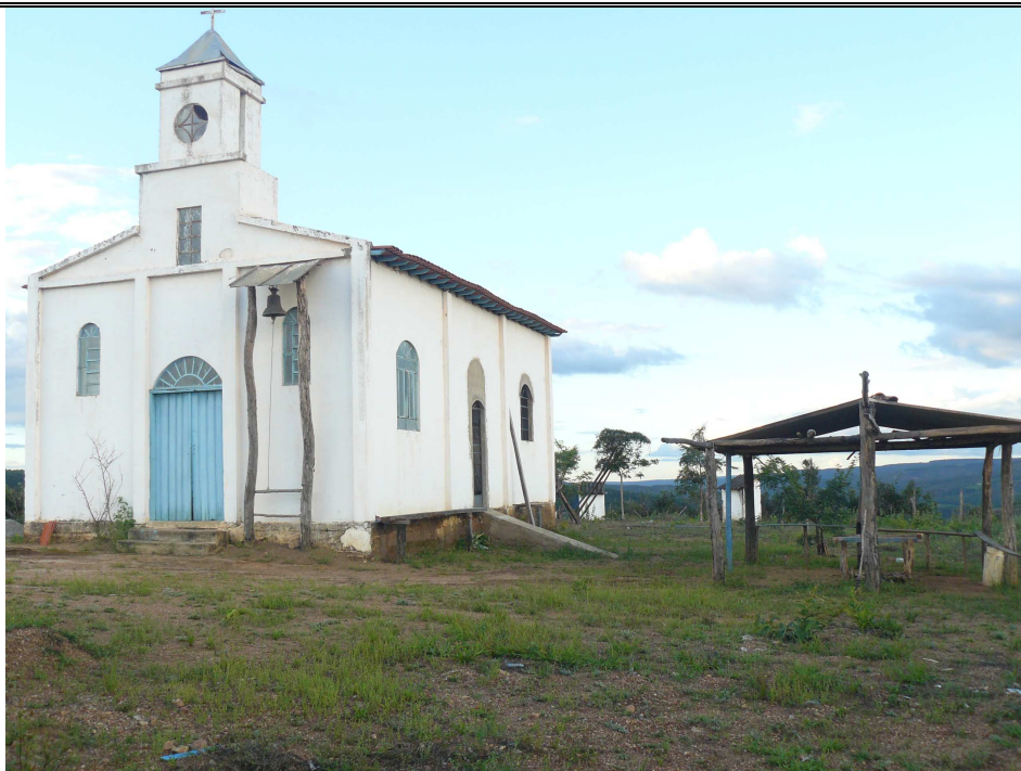
Foto 06- Igreja de Santa Terezinha – Fachada Frontal e Lateral Direita
