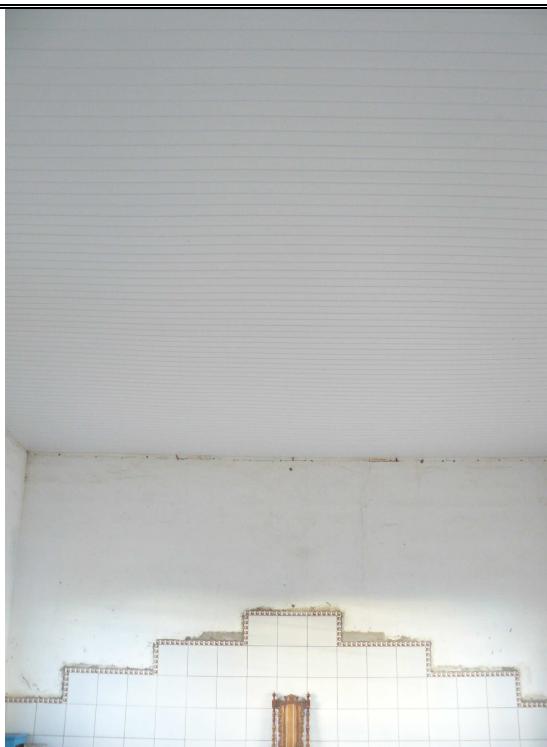
Foto 13- Igreja de Santa Terezinha – Detalhe altar e forro.
