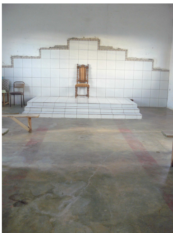
Foto 12- Igreja de Santa Terezinha – Detalhe Altar e piso
