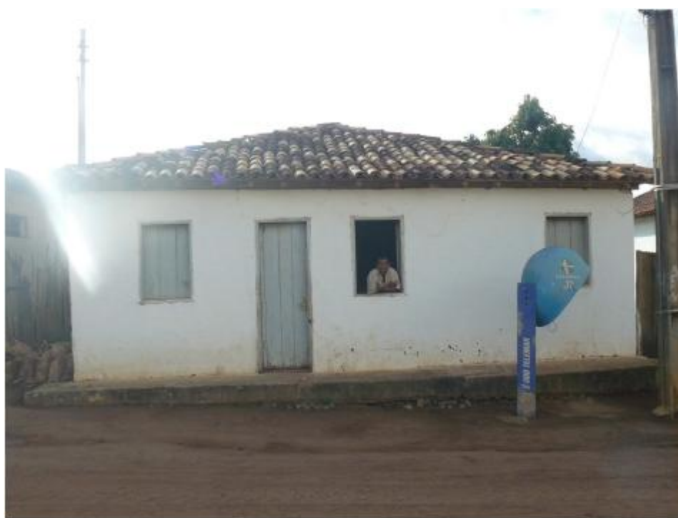
Foto 03 – Casa D. Maria de Jesus – Fachada frontal
