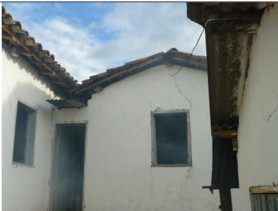
Foto 06- Casa D. Maria de Jesus – Vista fachada lateral direita e fundos
