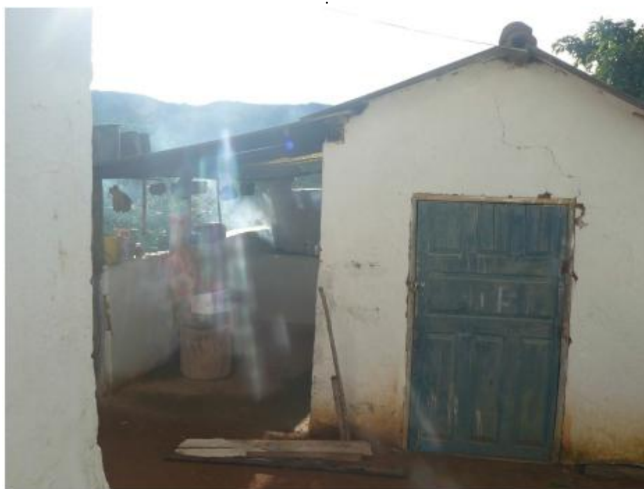
Foto 08- Casa D. Maria de Jesus – Vista construção anexa
