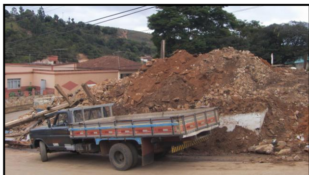
Escombros da edificação demolida
