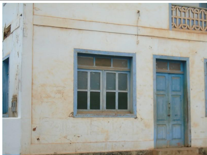
Residência de Jacinto Ribeiro – Vista de vãos da fachada. Data: 15/03/2017. Fotógrafo: Pedro Alcântara. Fotografias: Digitais.
