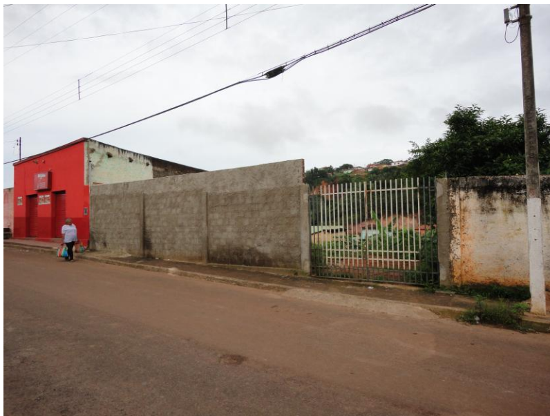
Lote após demolição
