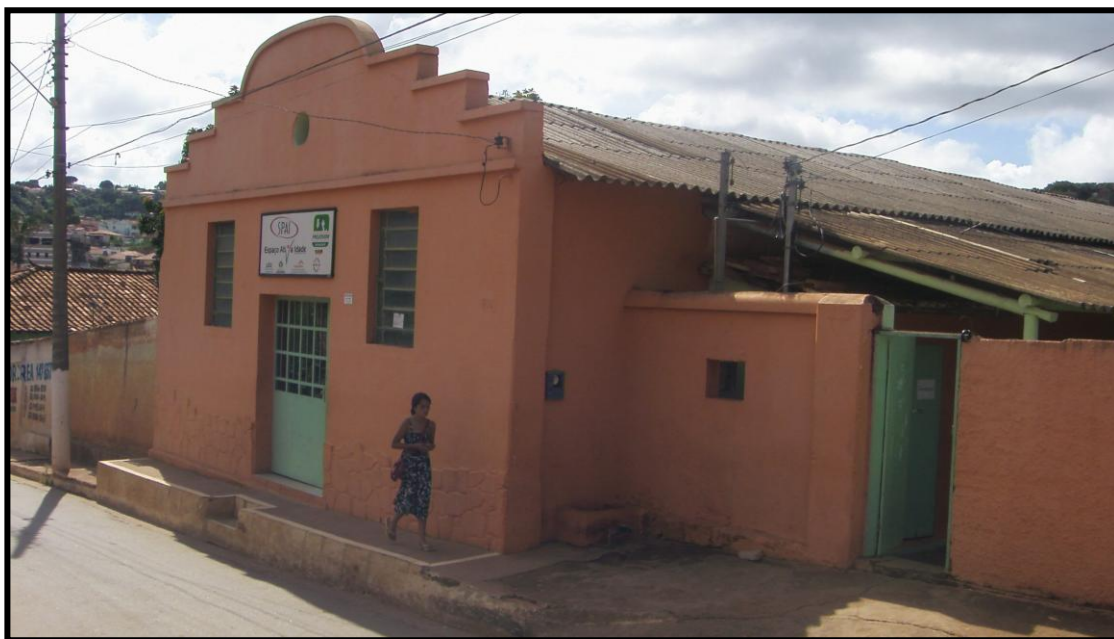
Fachada do Prédio
