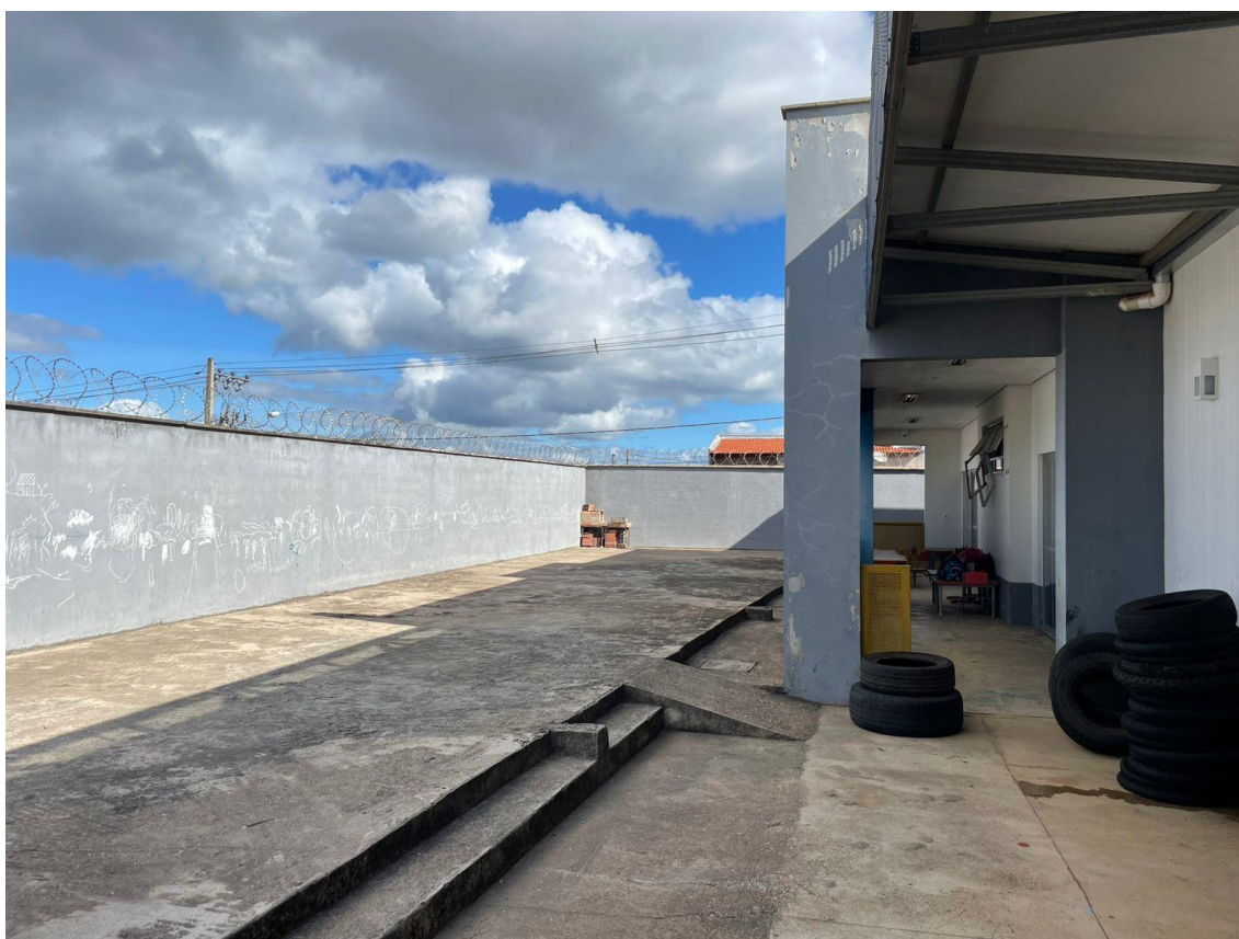
1- Local onde serão construídos as duas salas e os banheiros.
