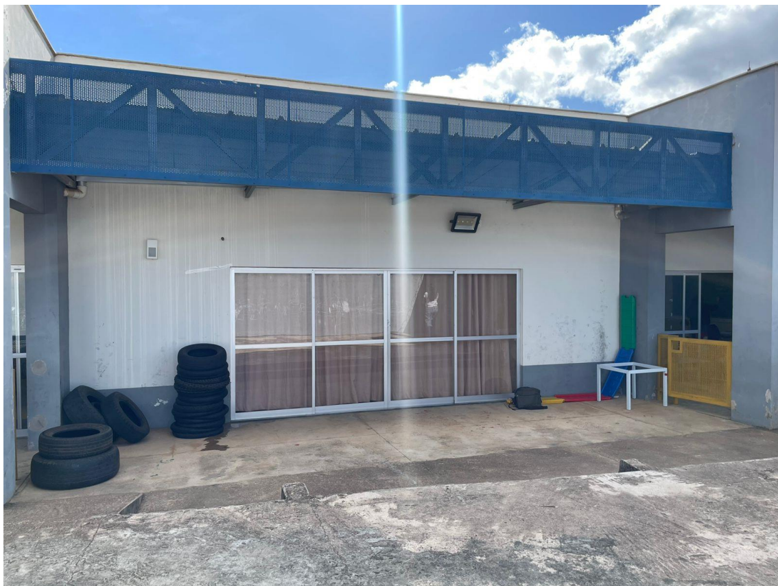
4- Local onde serão construídos as duas salas e os banheiros (entorno do CMEI).
