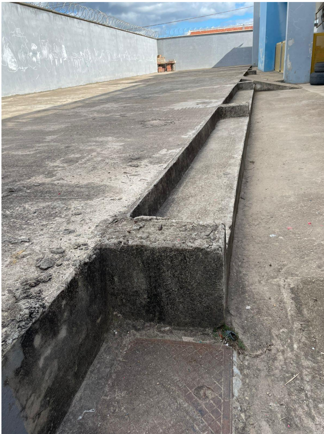
2- Local onde serão construídos as duas salas e os banheiros.
