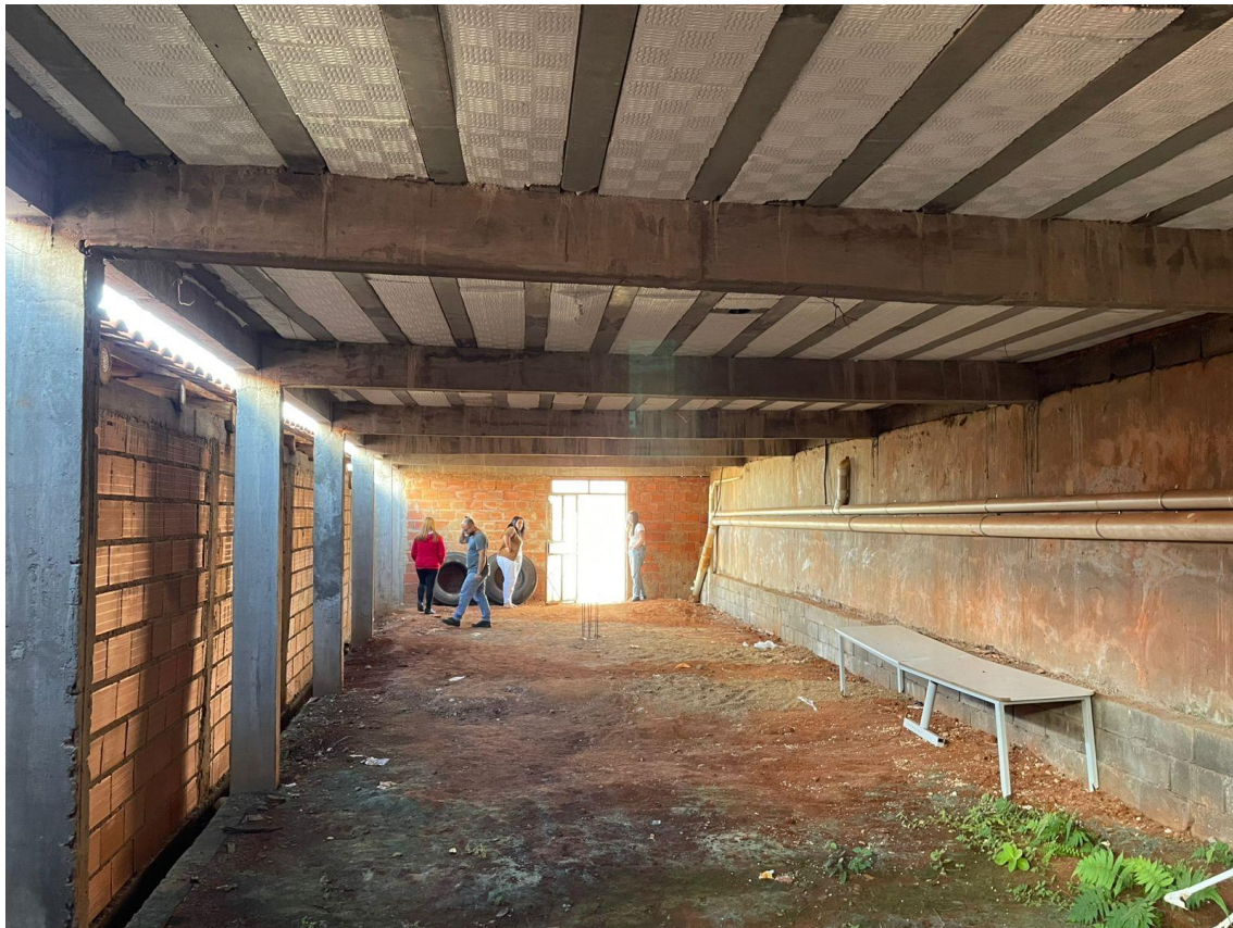
5- Subsolo, condições da estrutura de onde serão construídos as duas salas e os banheiros.
